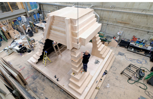
Construction de la pyramide de La Périhole © Cyrille Cauvet
